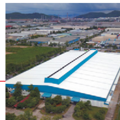
Fujitsu General (Thailand) Co., Ltd., второй завод
